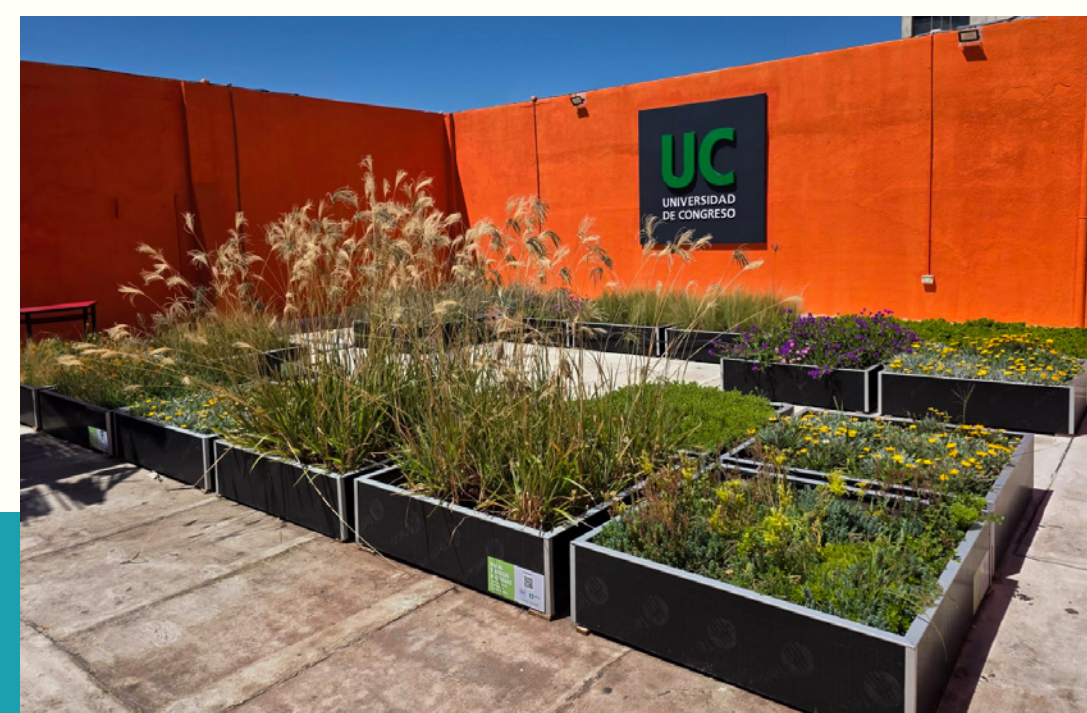
Terraza vegetada a los dos meses de su instalación.
